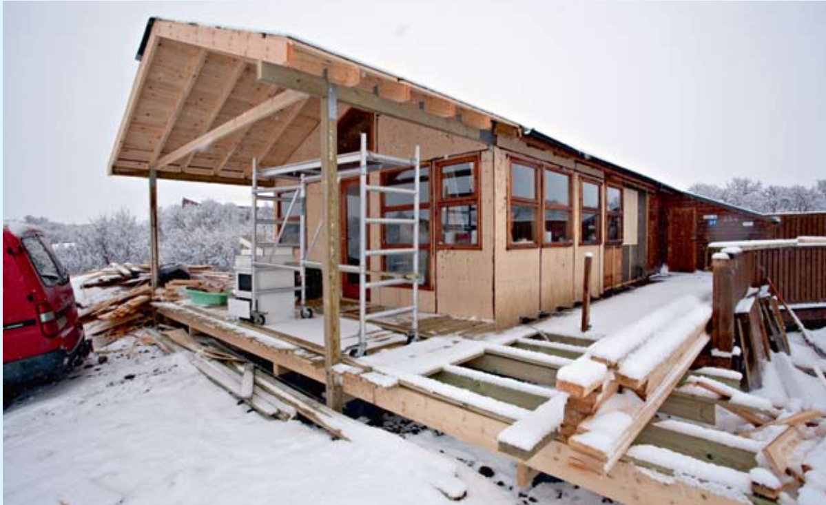
Orlofshús FIT í Svignaskarði, verið er að stækka húsið.
