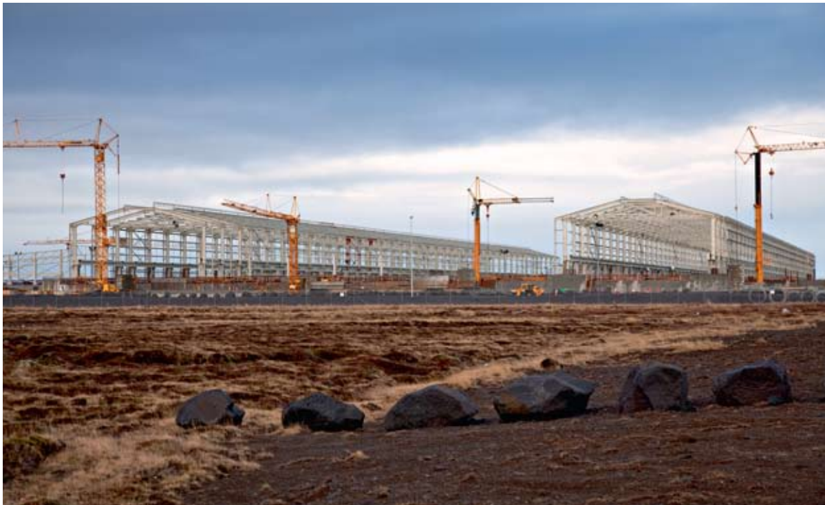
Kerskálur Norðuráls í byggingu.
