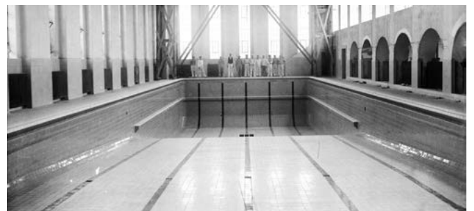
Iðnaðarmenn, sennilega múrarar standa við enda sundlaugar Sundhallar Reykjavíkur. Sundhöllin er í byggingu en búið er að flísaleggja lagina.
