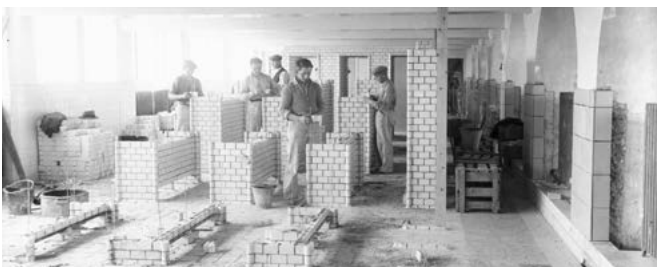
Múrarar að hlaða upp veggi og flísaleggja í búningsklefum Sundhallar Reykjavíkur. Múrarinng lengst t. h. er Jóhannes Bergsteinsson. Maðurinn fyrir miðju er Halldór Ari Björnsson
