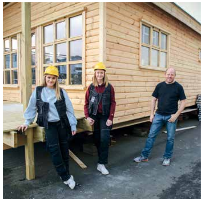
Lilja, Helga og Gunnar fyrir framan sumarhús í byggingu sem er árlegt verkefni hjá FS.
