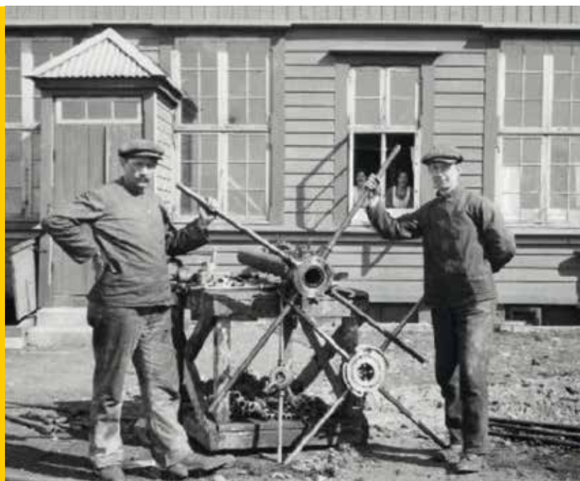
Tveir pípulagningamenn að snitta rör fyrir utan Holdsveikraspítalann í Laugarnesi, árið 1916. Ljósmyndari: Magnús Ólafsson.
